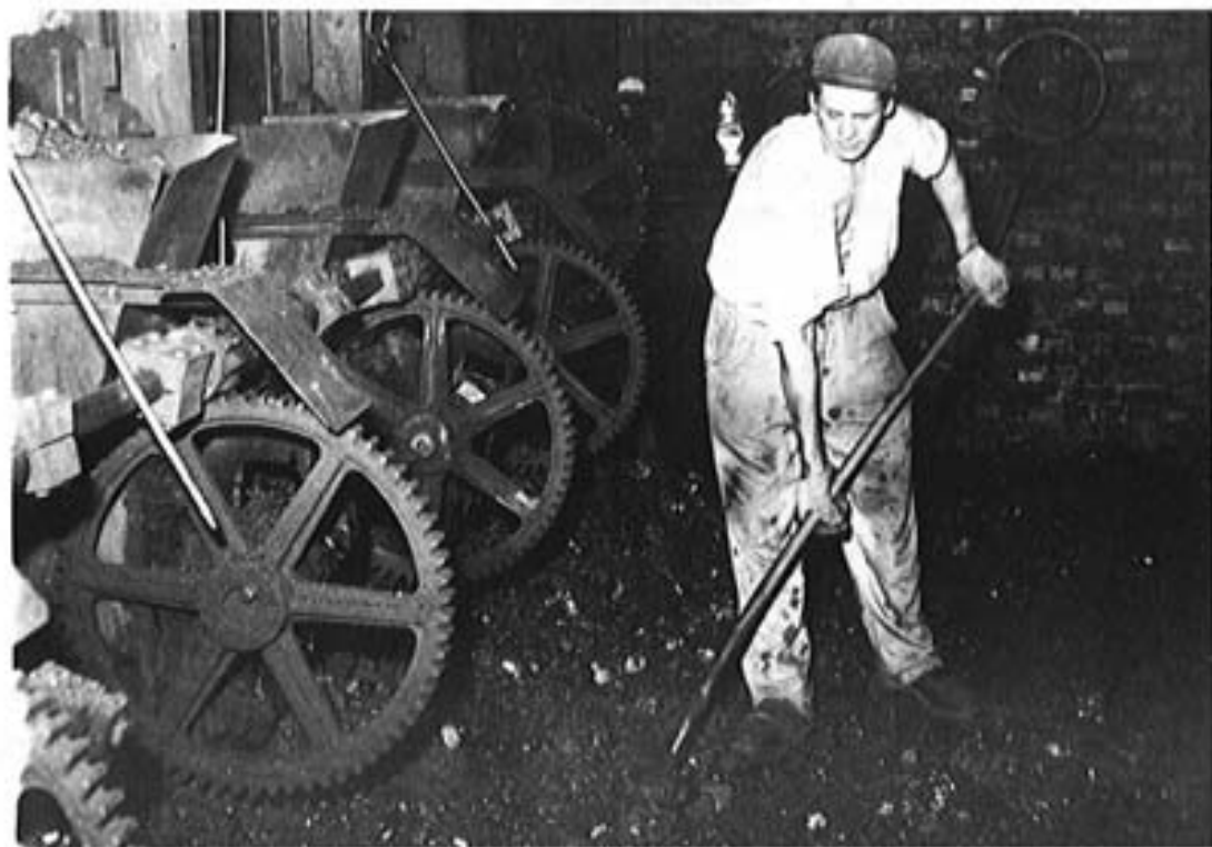
Die Kohlen wurden per Hand aus dem Eisenbahnwaggon in Kübel geschaufelt und dann mit dem Aufzug in das Generatorenhaus hochgehievt. Die Bestückung der Generatoren für die Gasaufbereitung erfolgte bis 1957 ebenfalls von Hand. (Aufn. 50er Jahre)
