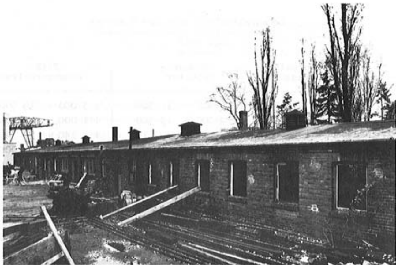
In dieser Baracke wurden während des Zweiten Weltkrieges Zwangsarbeiter untergebracht. Das Durchschnittsalter betrug 35 Jahre; die Durchschnittsaufenthaltsdauer 15 Monate.
